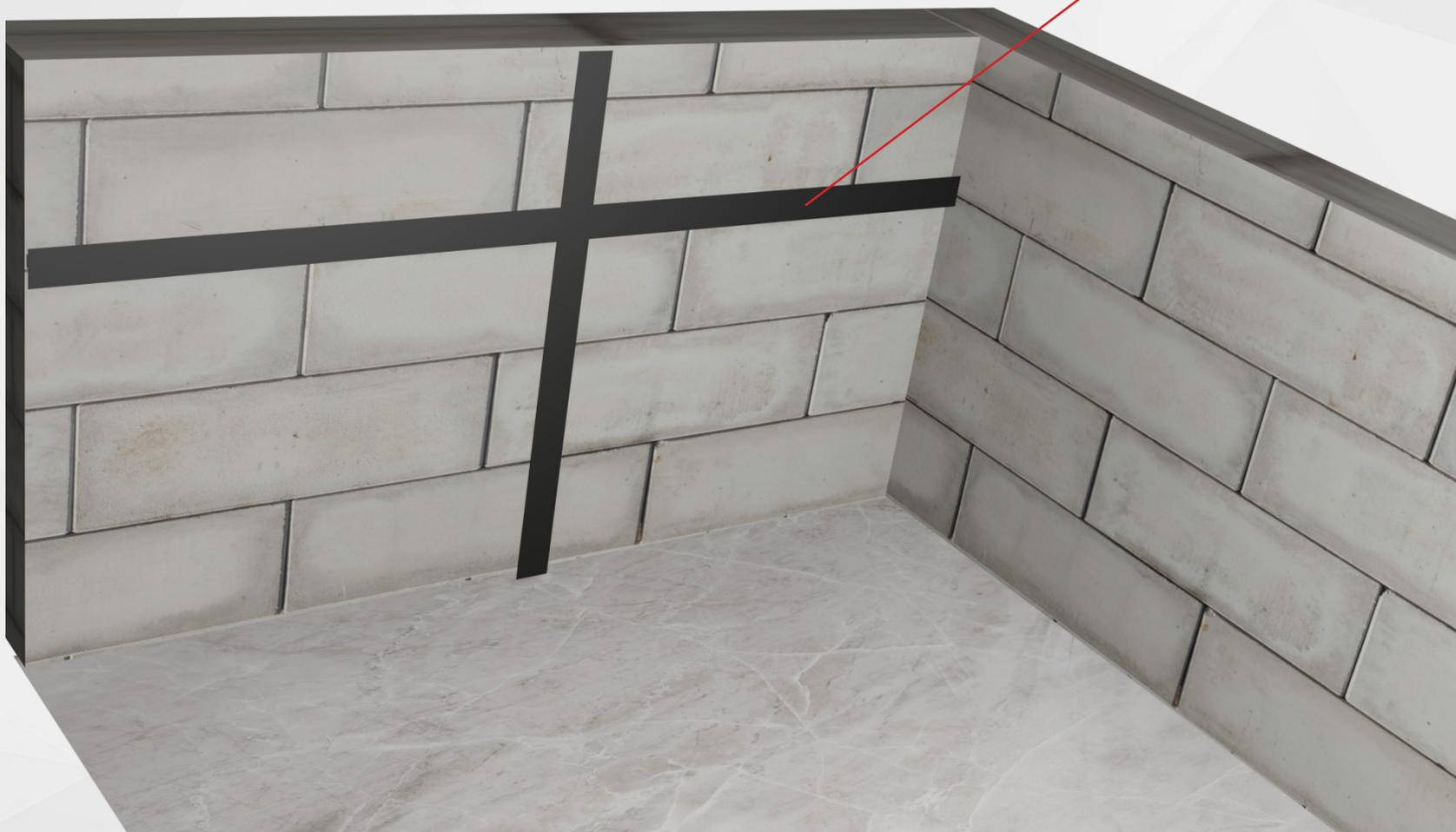
Нанесите клей на поверхность панели, соблюдая отступы от краев, чтобы при приклеивании, клей не выдавило за границы панели.
